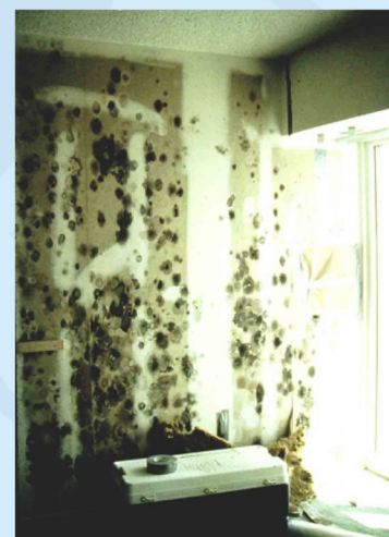
Fotografia de um quarto de hotel desocupado após retirada de laminado plástico em parede
